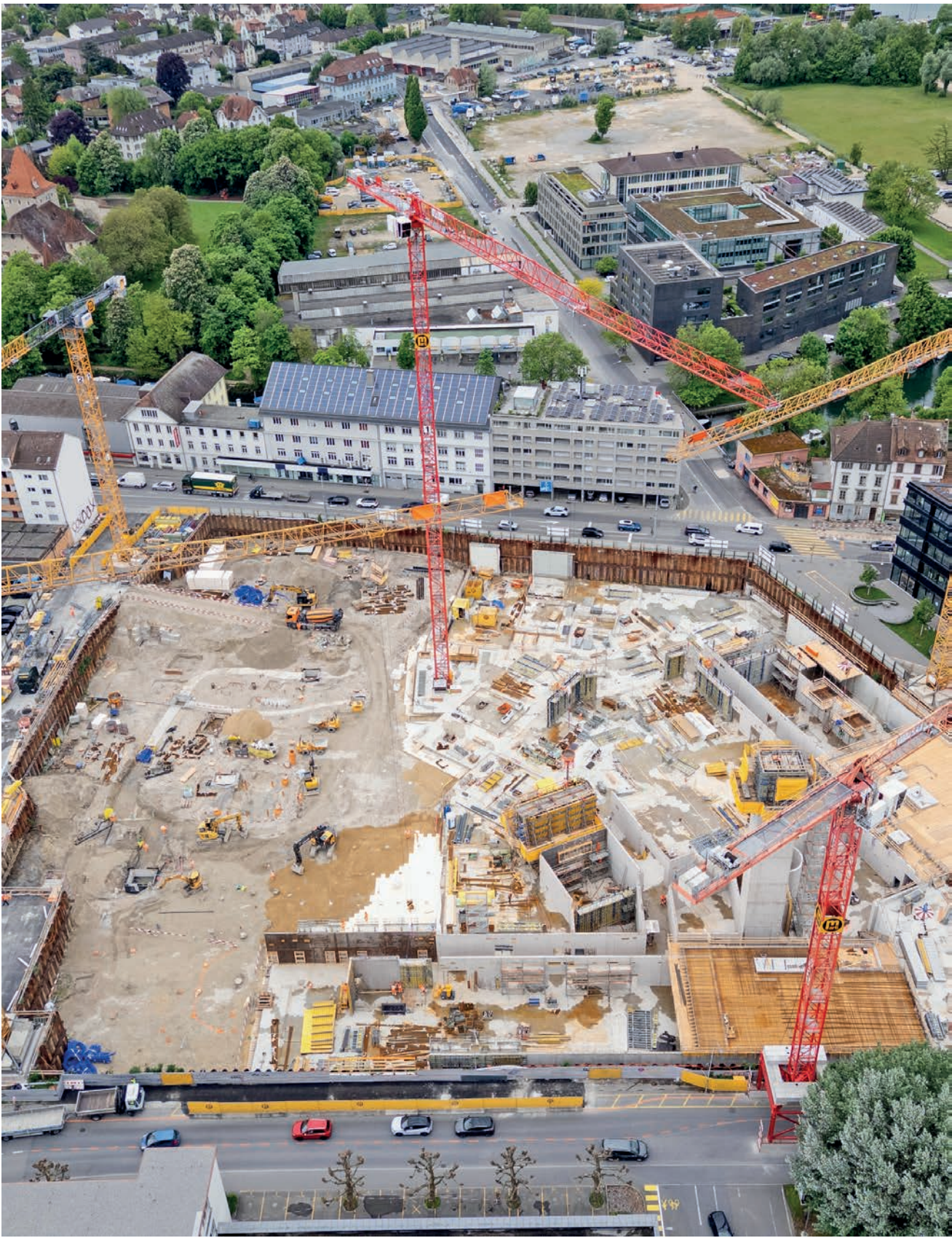
Désormais, le chantier entre dans une phase intensive de construction.
