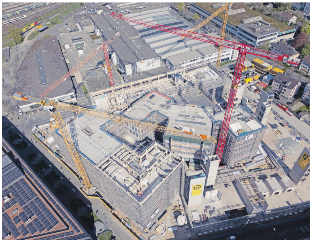
Blick von oben auf die Baustelle mit der Drohne.
