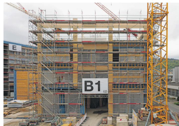
Auf der Baustelle wird in Etappen gebaut.
