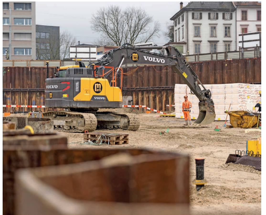
Bagger graben Löcher für Schächte und die Kanalisation.
