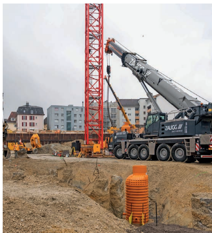
Derzeit entsteht das Erdgeschoss.
