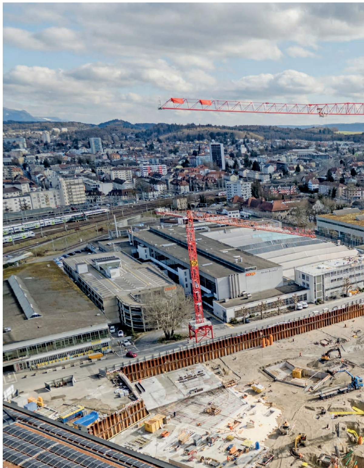
In der Baustelle des Campus Biel hätten zweieinhalb Fussballfelder Platz. Derzeit arbeiten dort zwischen
